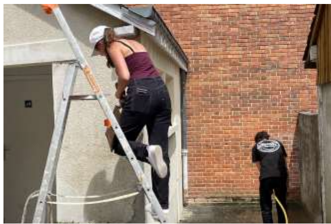
Ambre et Kylian, lessivage, décapage, peinture
