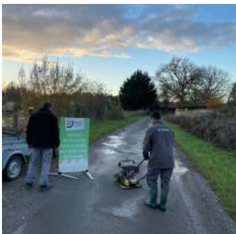
Chaque année il est important de reboucher les trous dans les chemins et voies communales grâce à l'apport de matériaux et l'utilisation d'une dameuse
