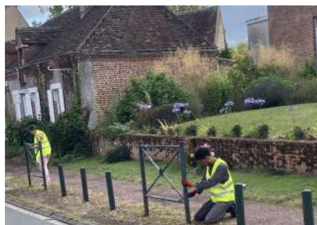
Julien et Angel à la rénovation des plots et barrières
